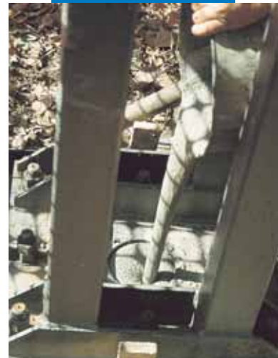
Anclaje con Mapefill
