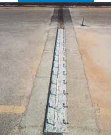
Reparación de juntas de puentes de carreteras con Mapefill
